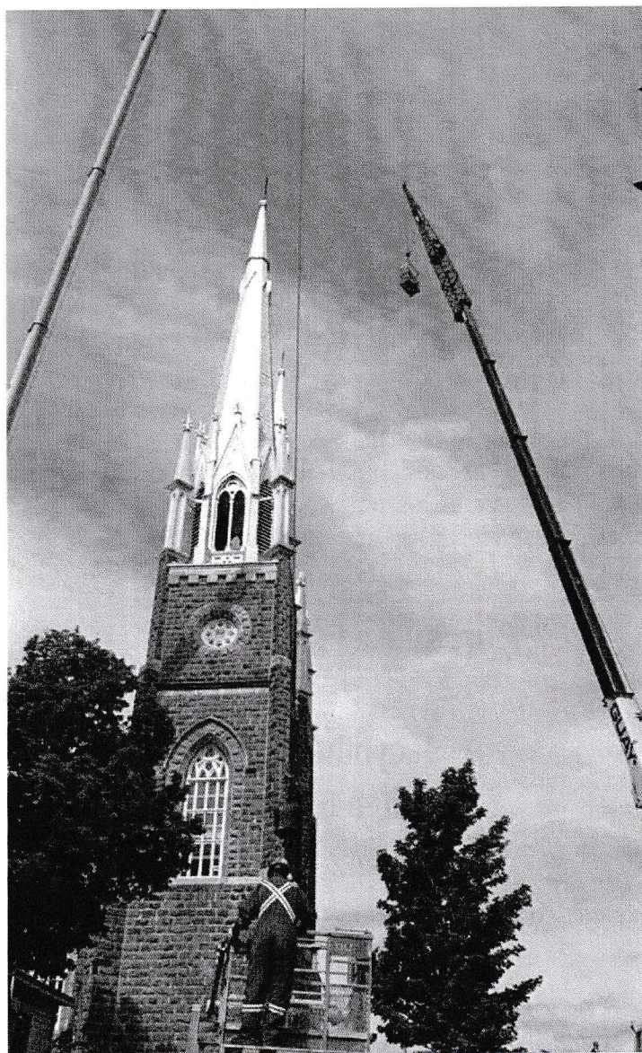
Démontage de la croix. Août 2020.
